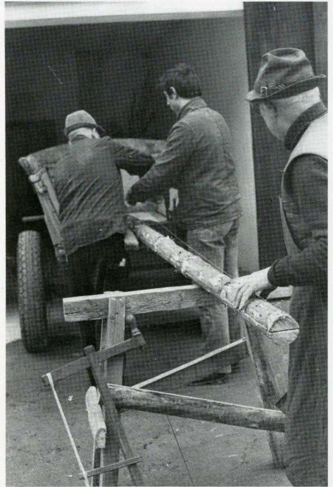
Schnurschlagen zur Markierung der Bohrstellen für die Zapfenlöcher
