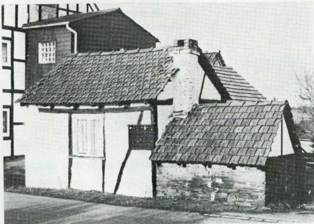
Backhaus Haus Vorländer, Gesamtansicht, Langenbach/Oberberg. Kreis; Foto: T. Ruse
