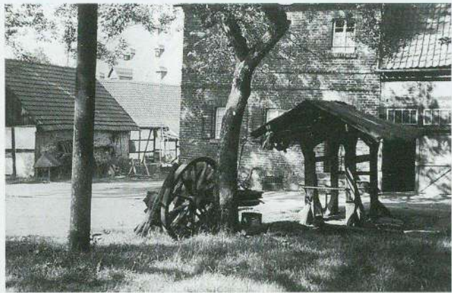
Die ehemalige, 1866 errichtete Herrenstrundener Schmiede Mäurer mit Notstall; Aufnahme um 1920.
