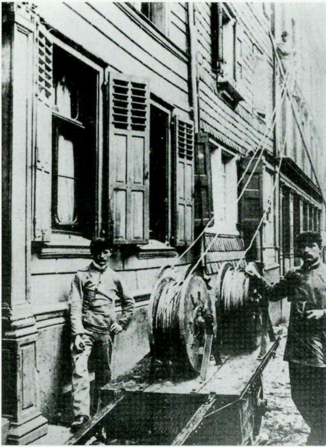
Das elektrische Licht kommt nach Bergisch Gladbach! Verlegen von Leitungen nach dem System Köttgen, (Foto: U. Jux)
