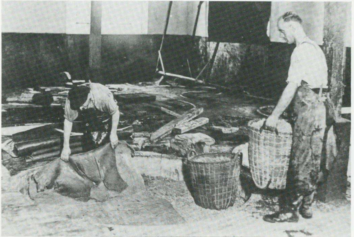
Versetzen der Häute (Blößen) in Gruben bei der Bensberger Gerberei Offermann
