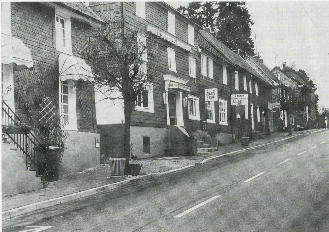
Verschieberte Häuserzeile in Nümbrecht
