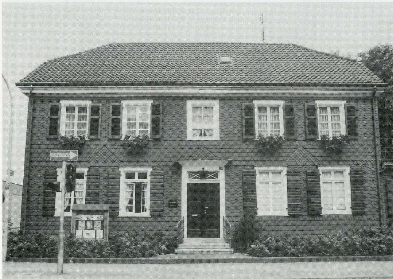
Fassadenverschieferung an Haus Gronau, Bergisch Gladbach, Hauptstraße
