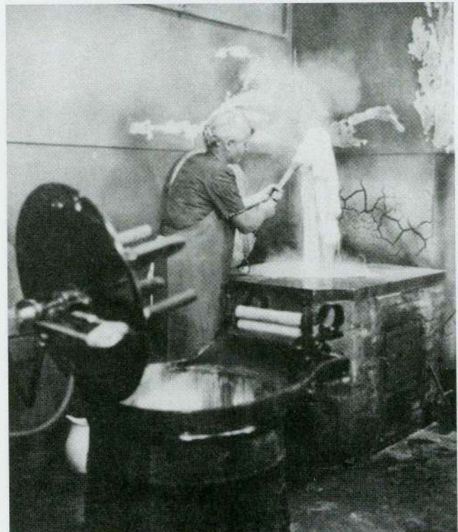
In der Waschküche mit Kochkessel und mit Wasserkraft betriebener Bottichwaschmaschine, um 1950 [7]
